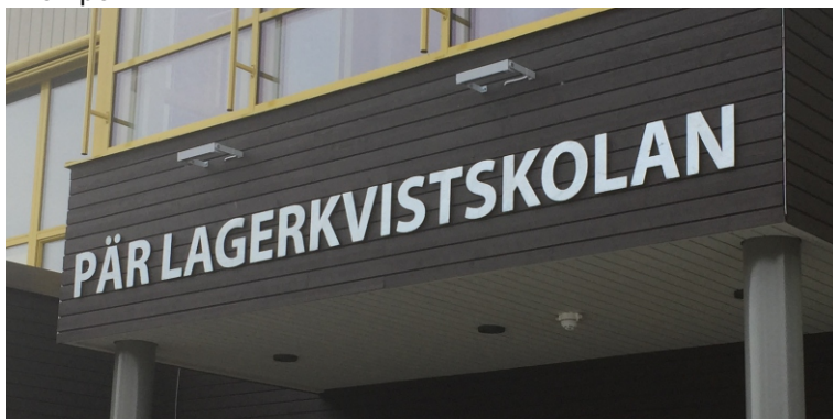
Plansågad text av 2mm lackerad al-plåt monterad på distans från vägg
