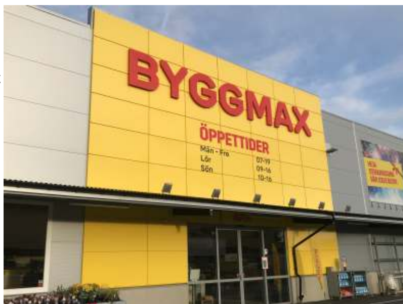
Bygghuset med skylt i Profil 01
